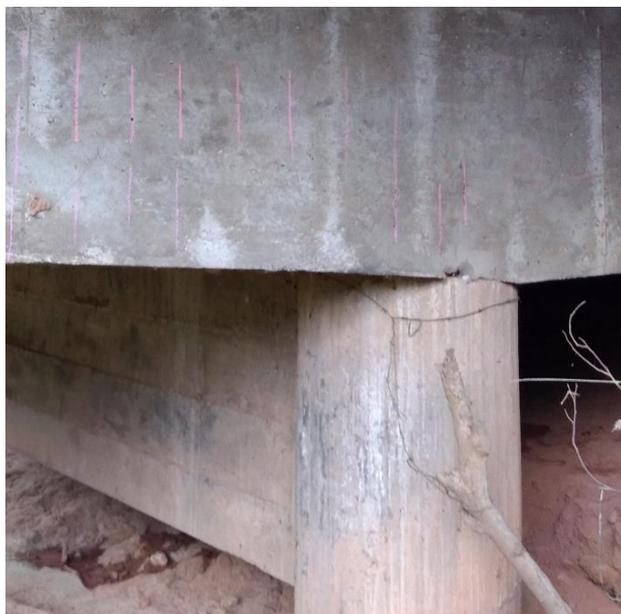
**Figura 4. Exemplo de ponte com aparelho de apoio não identificado.**
