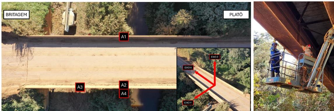
**Figura 2 – Instalação dos acelerômetros nos pontos de análise**
