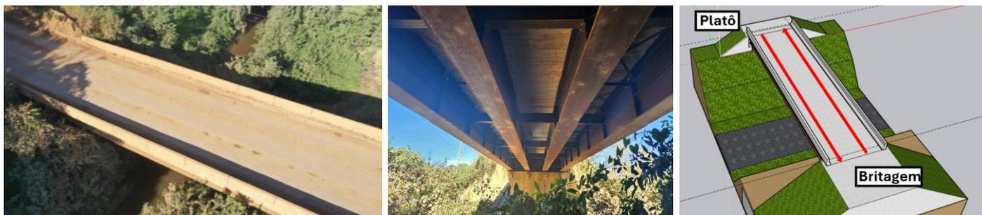
Figura 1 – Vista do tabuleiro e das transversinas da ponte.
