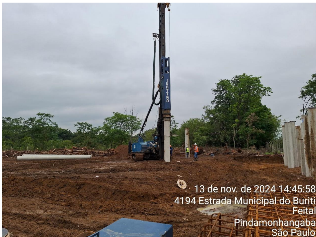
Figura 9 – Cravação das estacas do Apoio 3
