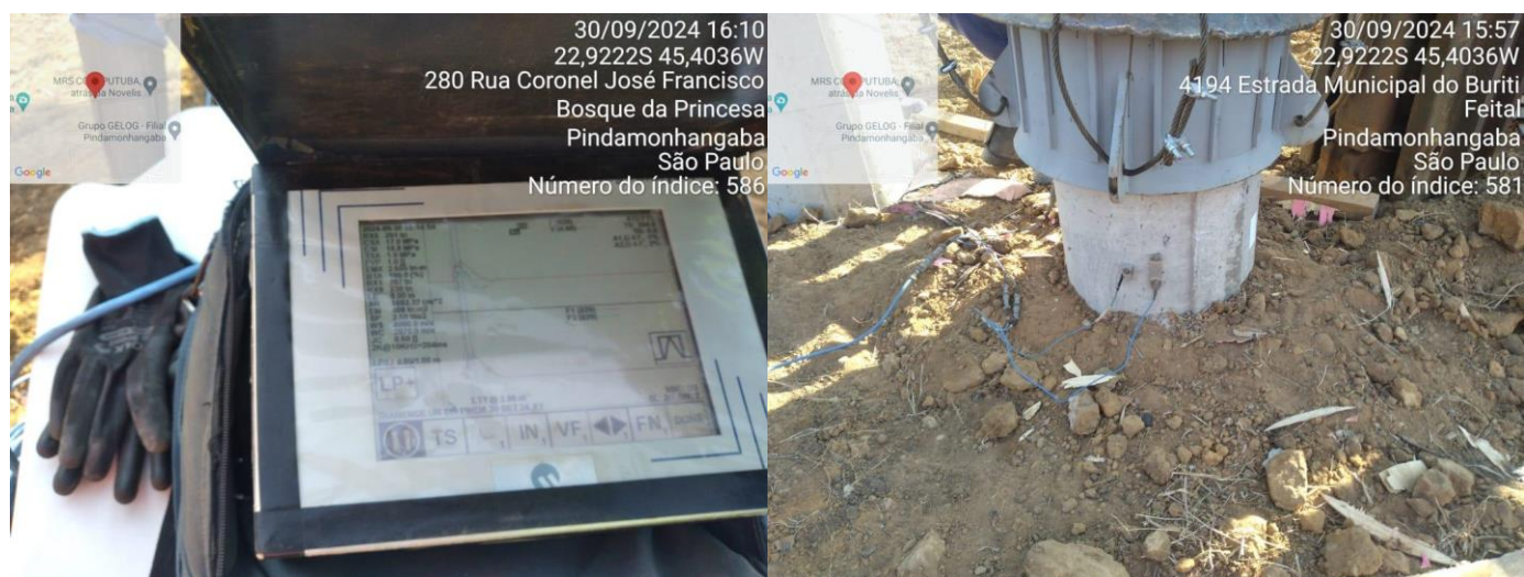
Figura 10 – Execução dos ensaios PDA
