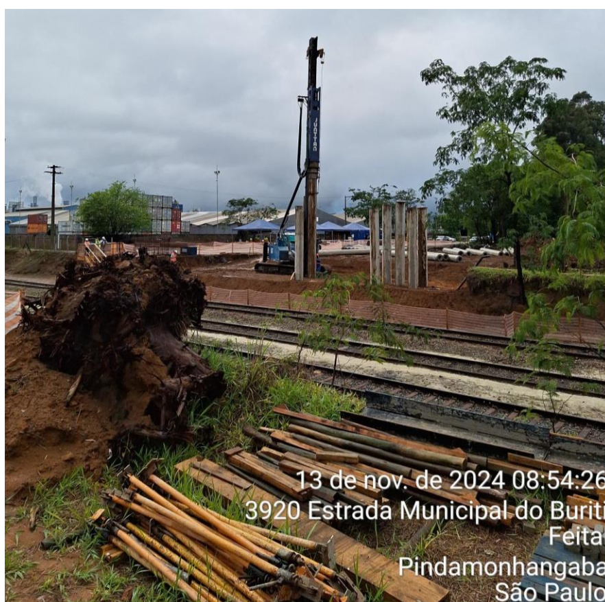
Foto 8 – Cravação estaca E24 [Apoio 2]
