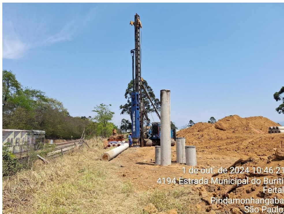
Figura 7 – Cravação da Estaca E9 [Apoio 1]
