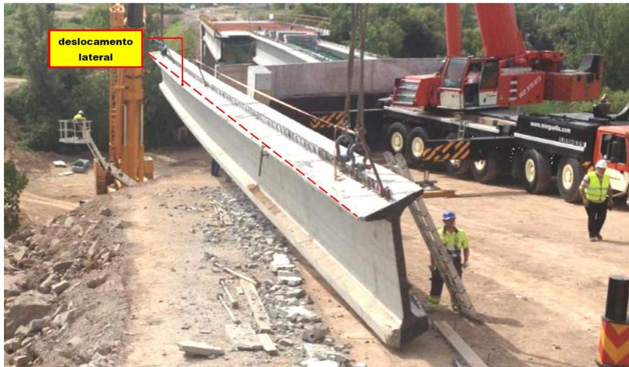
Figura 1 – Vista de viga com instabilidade lateral durante levantamento (GERMÁN, 2015).
